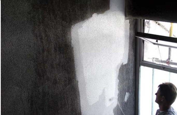
Renovierung eines Brandschadens mit zweimaligem Anstrich.
